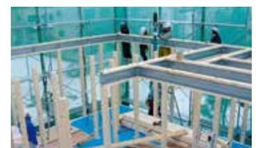
耐震性能を確認するため、震度7相当の揺れを複数回与える実験を実施。その結果、主要構造体に損傷などは見られず、強度が実証されました。
